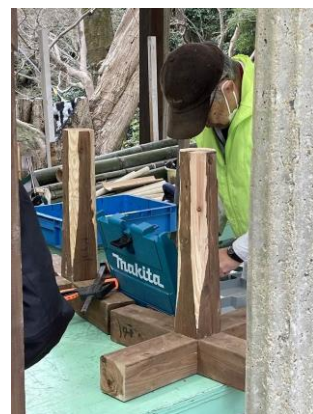
全体を支える重要な部分
