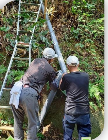
③排水管の設置
